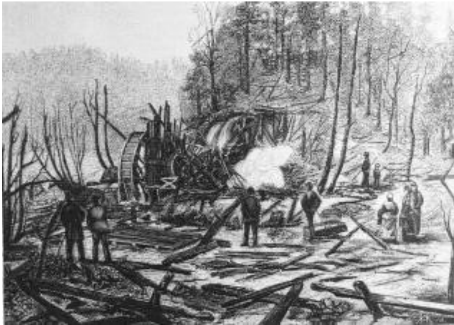
Kruttmøllen etter eksplosjonen. Vannet som drev vannhjulet kom fra høyre i bildet fra Liandalens dam. (Fint folk i bratte bakker)
